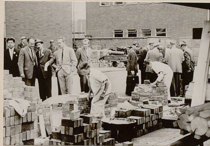
Im Bauhof der Hüttenwerke Rheinhausen
