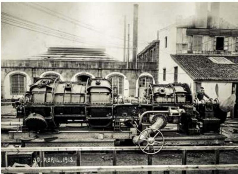
■ Turbina *Parsons* fabricada en Ferrol para uno de los acorazados de clase España. La fabricación de turbinas será uno de los puntos fuertes del astillero ferrolano tras la llegada de la SECN 1913
